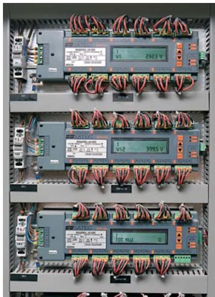
▲ Рис. 2. Размещение многофидерного электросчетчика BFM136 при монтаже
