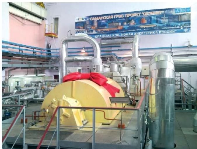
▲ Рис. 1. Новый турбоагрегат ПТ-12-2,9/0,6 ст. №1
